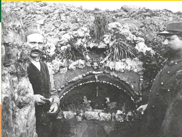
Crèche dans une tranchée
